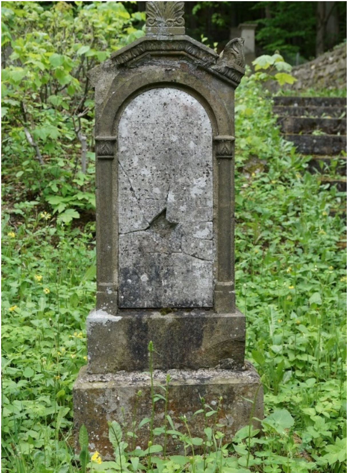
Abbildung 3: Beschädigte Texttafel aus weißem Hartgestein auf dem jüdischen Friedhof in Bleicherode (Foto v. Verf. 2021)
